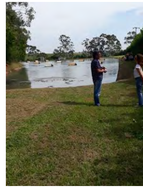
Figura 22 – Estação de tratamento de esgoto
