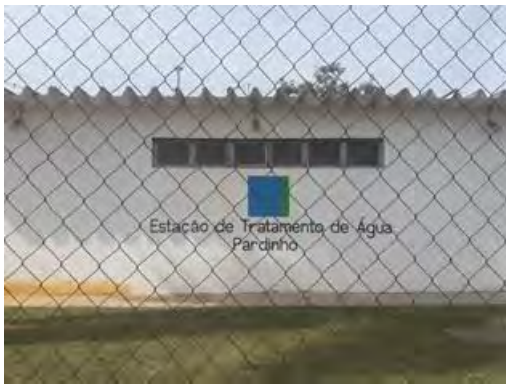
Figura 23 – Estação de tratamento de água
