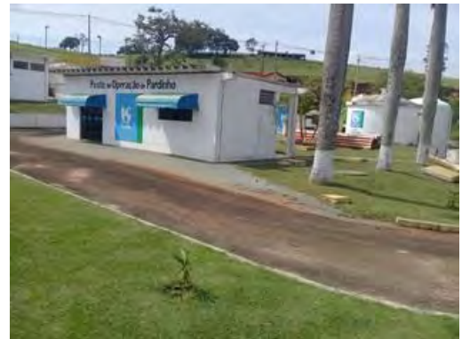
Figura 24 – Estação de tratamento de água
