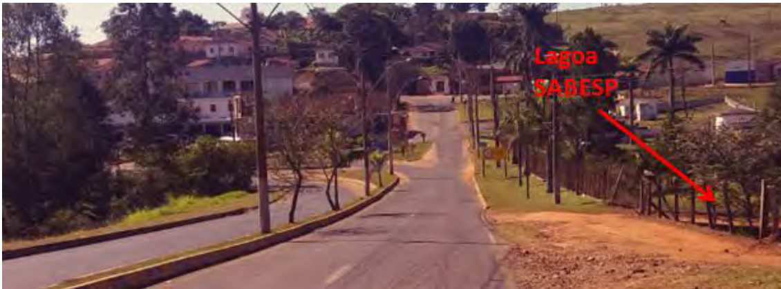
Figura 19 - Trecho da Estrada Municipal onde Ocorrem Inundações
