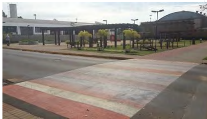
Figura 36 – Faixa elevada no Parque Linear
