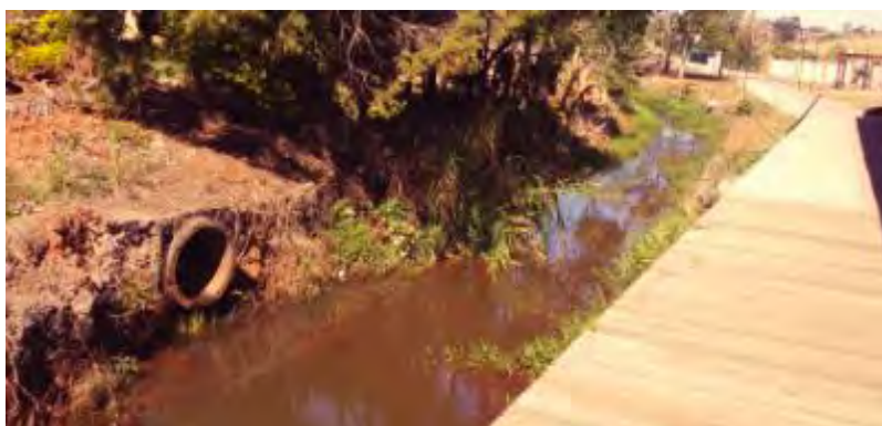
Figura 17 - Lançamento da galeria no Rio Pardo
