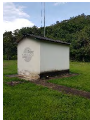
Figura 44 – Captação de água.
