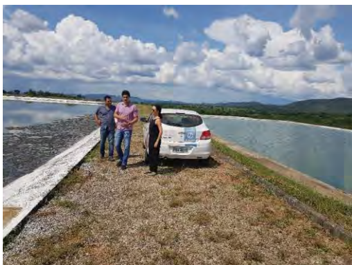
Figura 41 – Estação de tratamento de esgoto.
