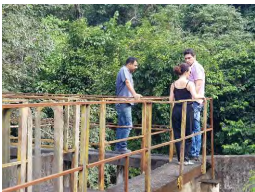
Figura 43 – Captação de água.
