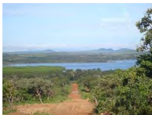
Figura 28 – Usina Serra da Mesa.
