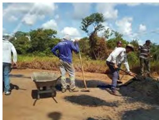
Figura 26 – obras em andamento.
