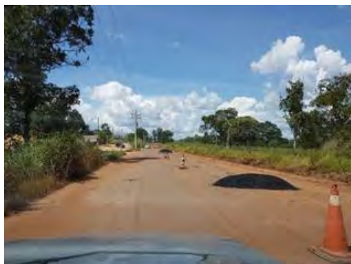
Figura 25 – obras em andamento.
