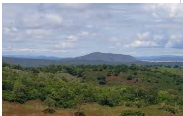
Figura 27 – Usina Serra da Mesa.
