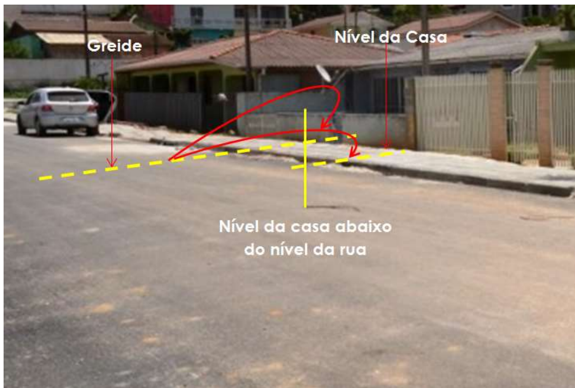
Figura 22. Problemas de micro drenagem associados às obras de pavimentação. Fonte IU.
