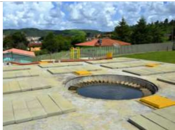
Figura 48. Estação de Tratamento de Esgotos. Fonte IU.
