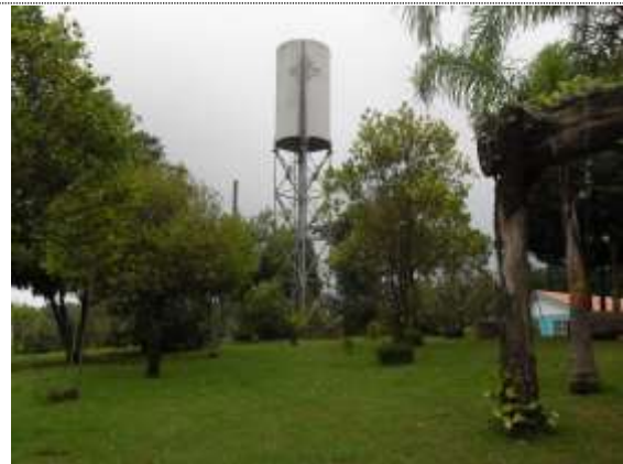
Figura 54. Reservatórios Pombas. Fonte IU.
