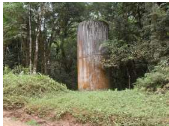
Figura 58. Reservatório no Canelão. Fonte IU.
