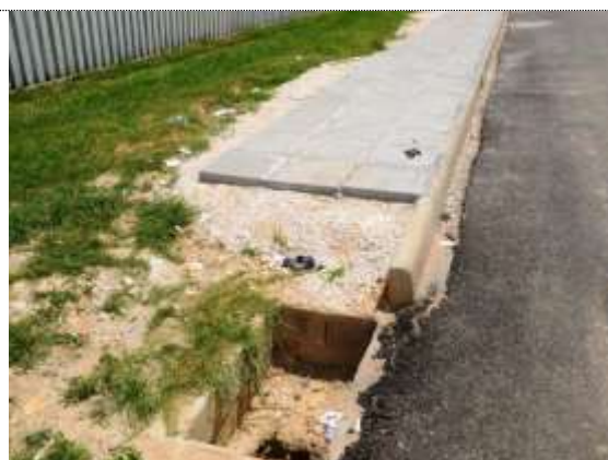
Figura 27. Boca de Lobo: Execução. Fonte IU.
