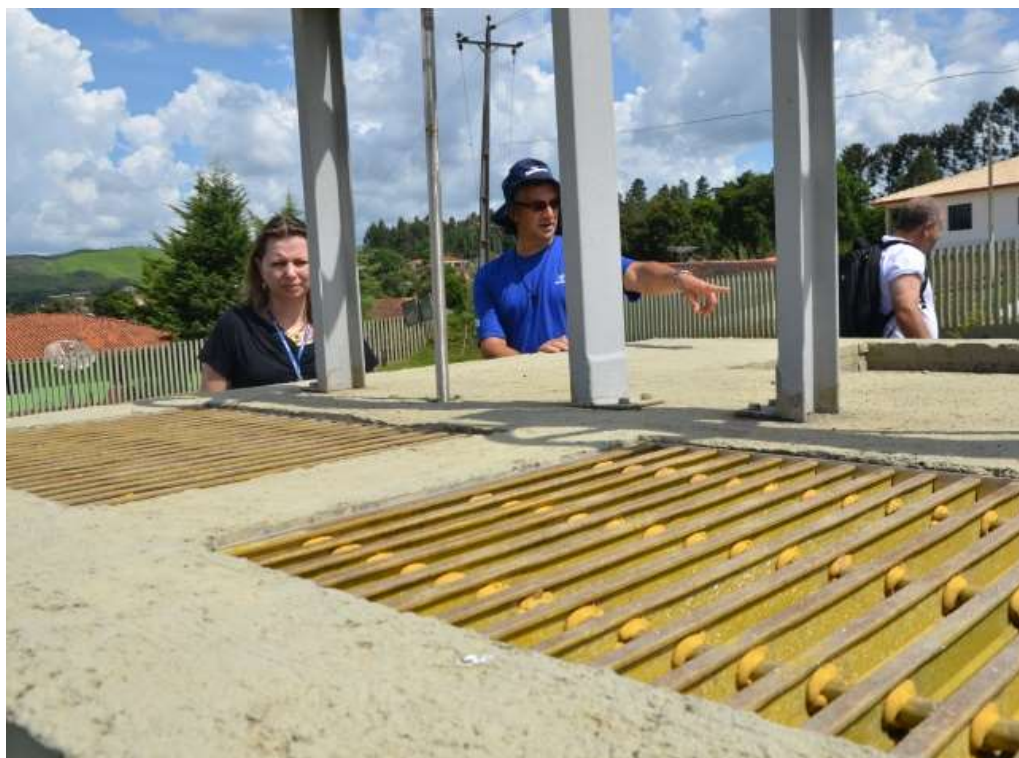
Figura 15. Visita à Estação de Tratamento de Esgotos da Zona Urbana de Itaperuçú. Fonte IU.
