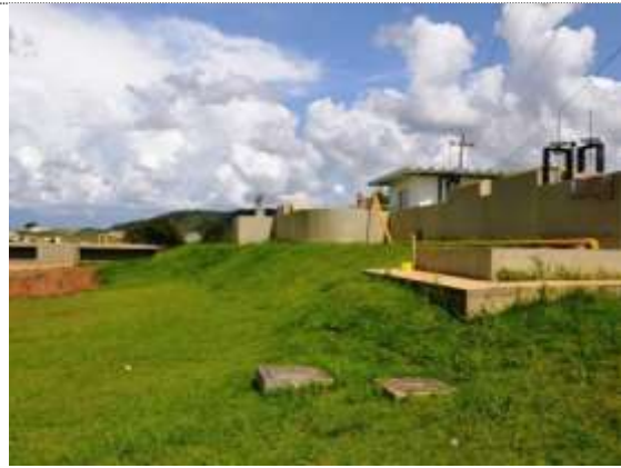
Figura 10. Estação de Tratamento de Esgotos. Tratamento Preliminar. Fonte IU.
