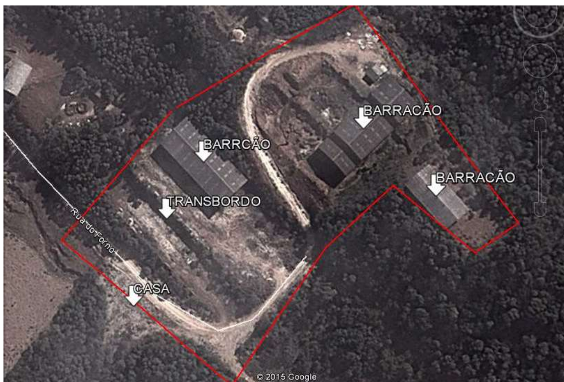
Figura 32. Localização das dependências da Estação de Transbordo. Fonte Secretaria de Obras.
