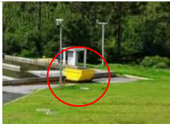
Figura 47. Estação de Tratamento de Esgotos e Caçamba para Retirada de Resíduos da ETE (Lodo). Fonte IU.
